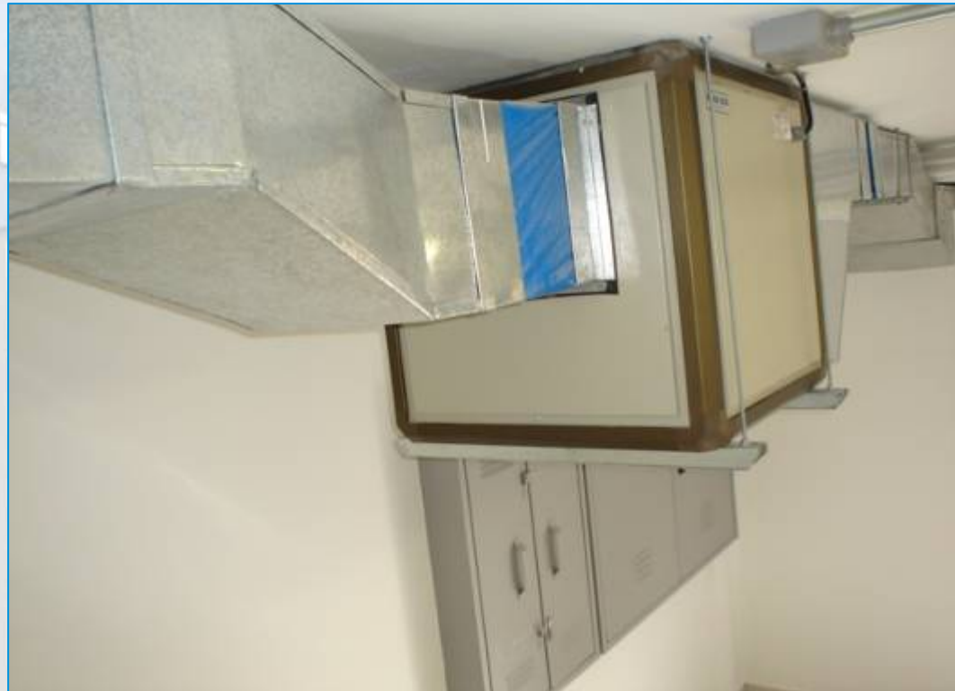
Sistema de Pressão Positiva de ar (no estoque), controlada com programador horário (Série 12) para evitar acúmulo de poeira
