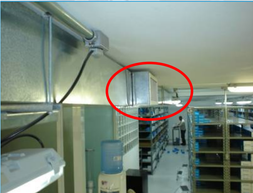
Sistema de Pressão Positiva de ar (no estoque), controlada com programador horário (Série 12) para evitar acúmulo de poeira
