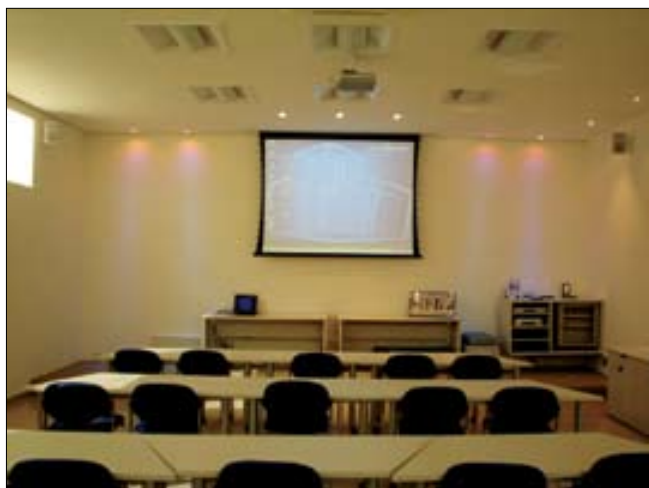
Segundo estágio: com o segundo pulso, o cenário de lâmpadas dicróicas se acende e o cenário de lâmpadas frias se apaga (apenas o 2º contato está fechado)
