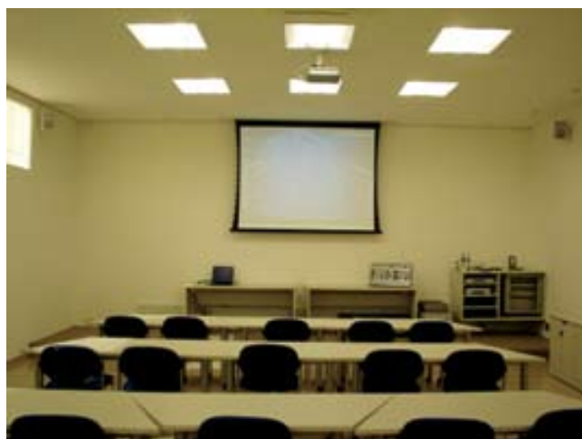
Segundo estágio: com o primeiro pulso, o cenário de lâmpadas frias se acende (apenas o 1º contato está fechado)
